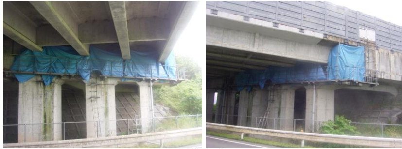
シート養生状況
