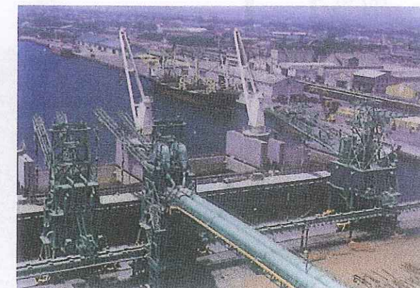
▲石巻埠頭サイロ (株) アンローダー・コンベア
